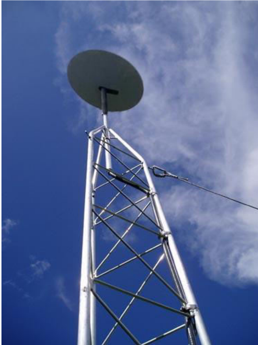
Figura 8.3.6. Antena de cliente Starlink montada en un mástil para una vista clara del cielo (Imagen con derechos de autor © SpaceX 2021).
