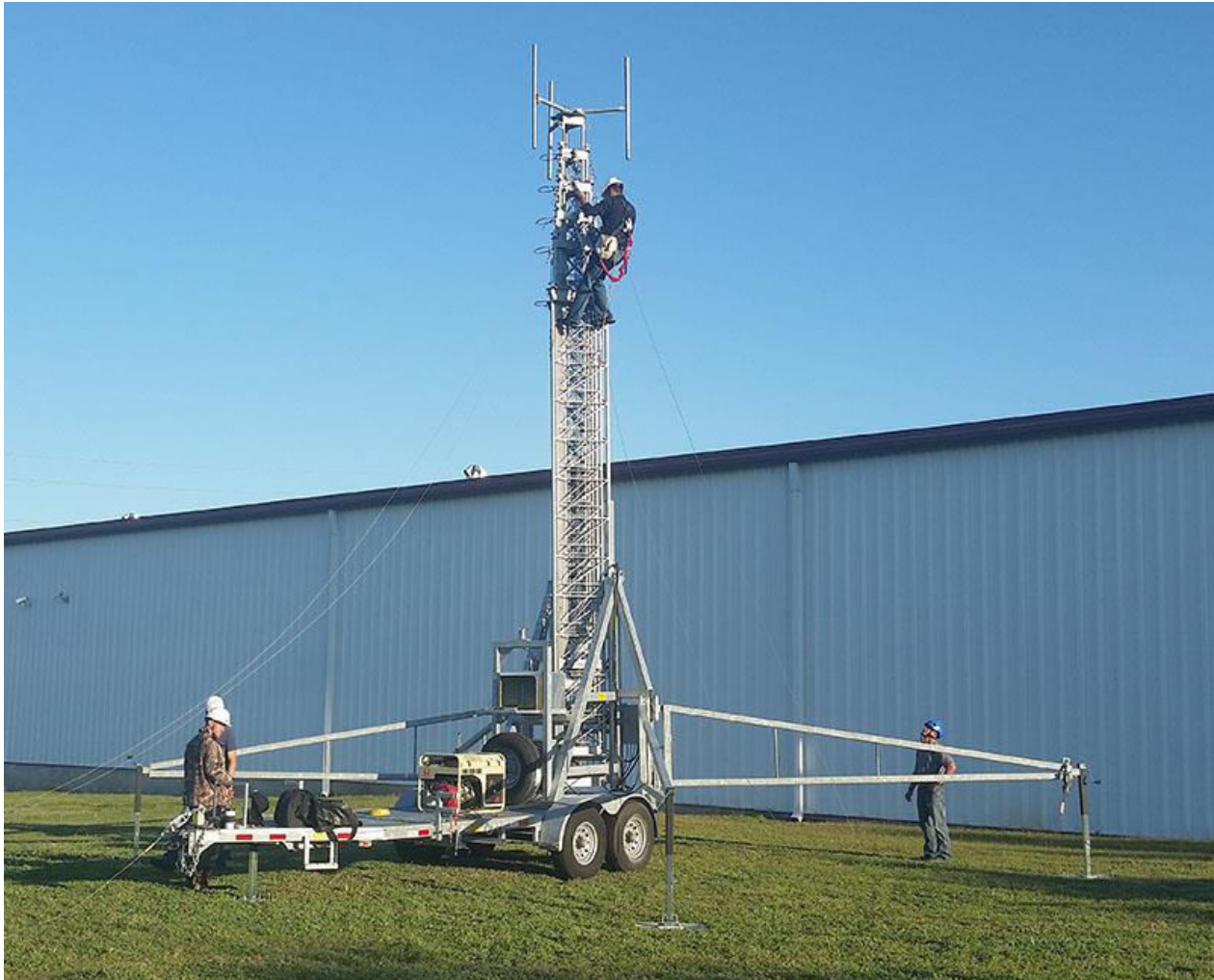
Figura 2.15.2. Un mástil de antena móvil montado en un remolque.
