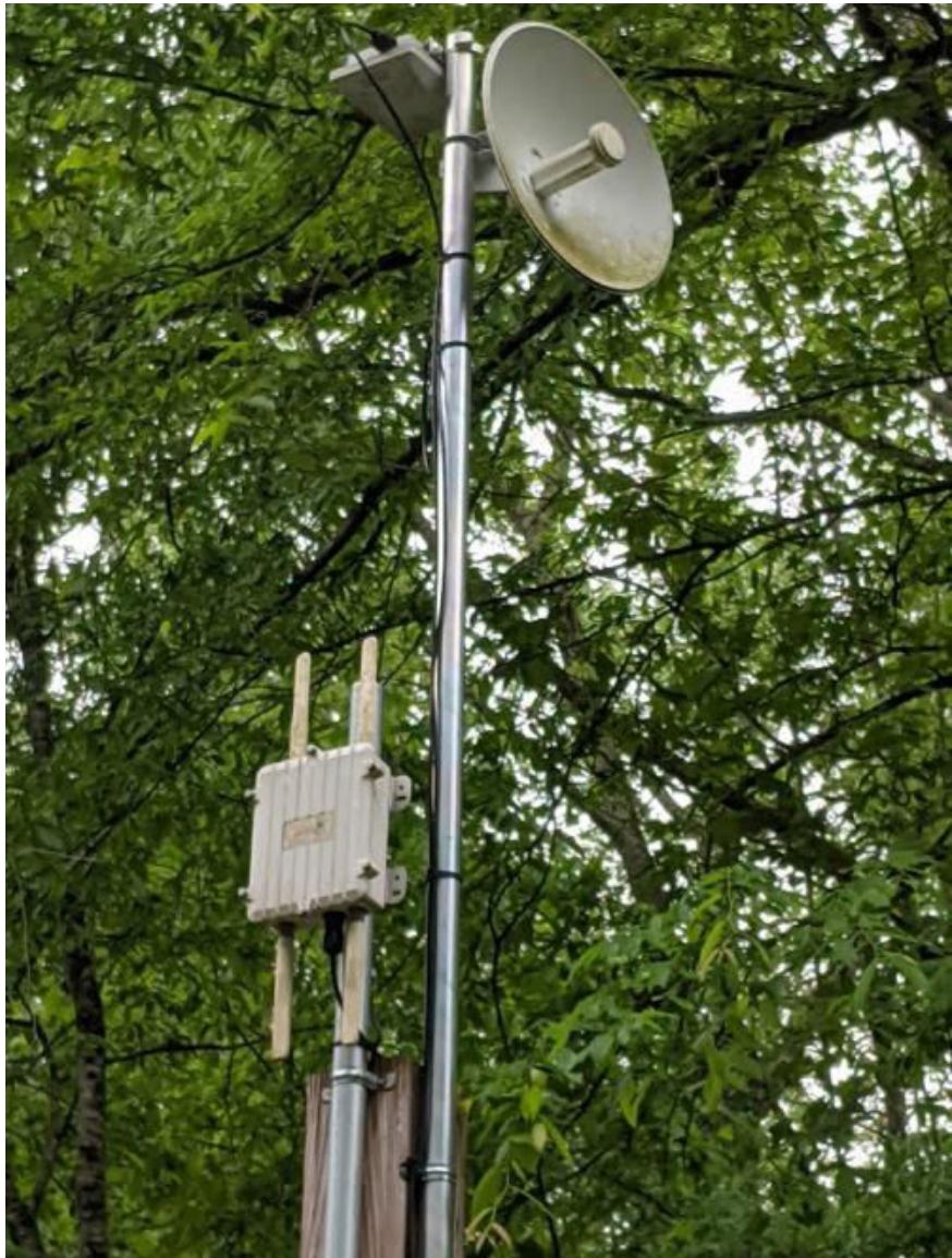
Figura 2.6.1. Una instalación de Hotspot de campamento de banda ancha móvil con un punto de acceso inalámbrico PtMP y una antena de backhaul PtP proporciona Internet para los visitantes y se realiza un cargo a pedido por el servicio.
